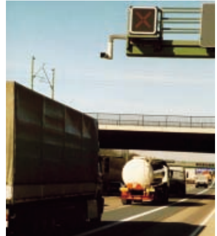
Bild 3: Deutsche Autobahnen gelangen an ihre Kapazitätsgrenzen; moderne Video-Management-Systeme können helfen, z. B. bei hoher Verkehrsdichte den Standstreifen als Fahrstreifen freizugeben.
