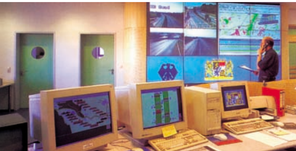
Bild 1: Verkehrsrechnerzentrale Südbayern: Die Bilder lassen sich wahlweise auf sechs Einzelmonitore oder auch auf eine große Multimediawand schalten.
